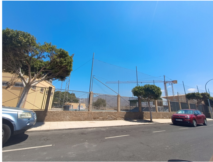
Terrenos de pistas polideportivas Calle Málaga
