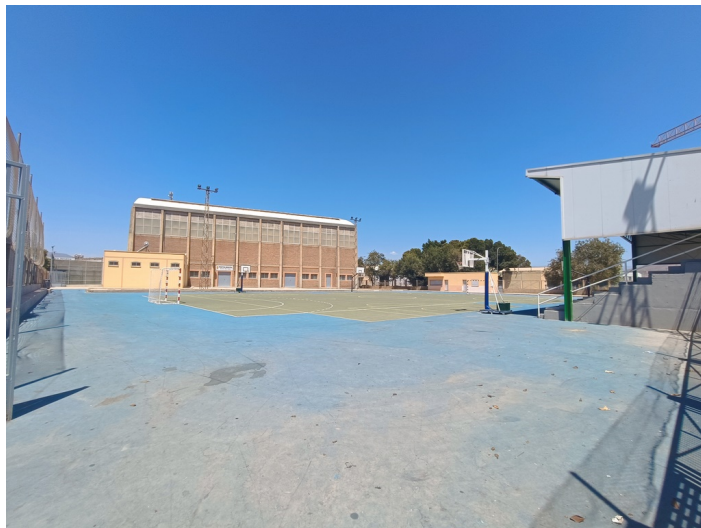
Terrenos de pistas polideportivas Calle Málaga
