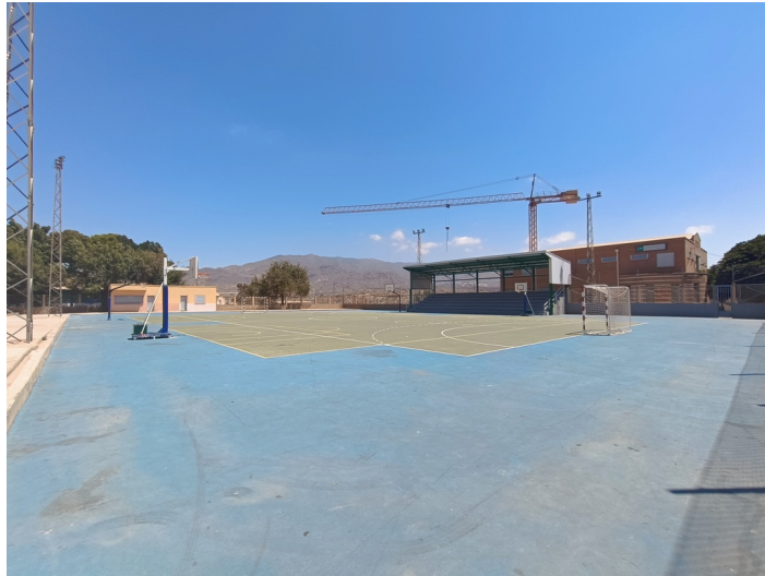
Terrenos de pistas polideportivas Calle Málaga
