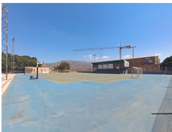
Pistas Polideportivas descubiertas c/Málaga
