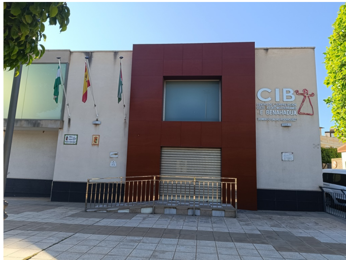
Fachada exterior edificio
