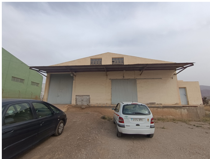
Imagen fachada principal
