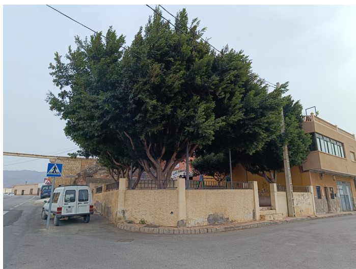
Vista exterior desde carretera
