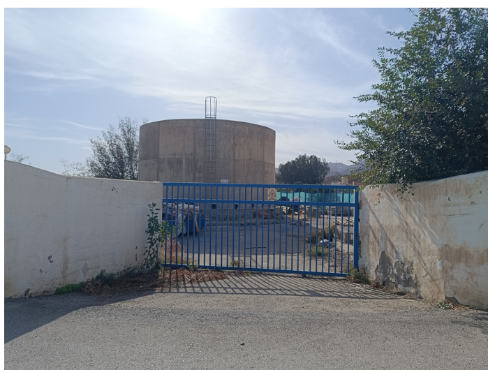
EDAR Estación Depuradora DS. CM Pechina
