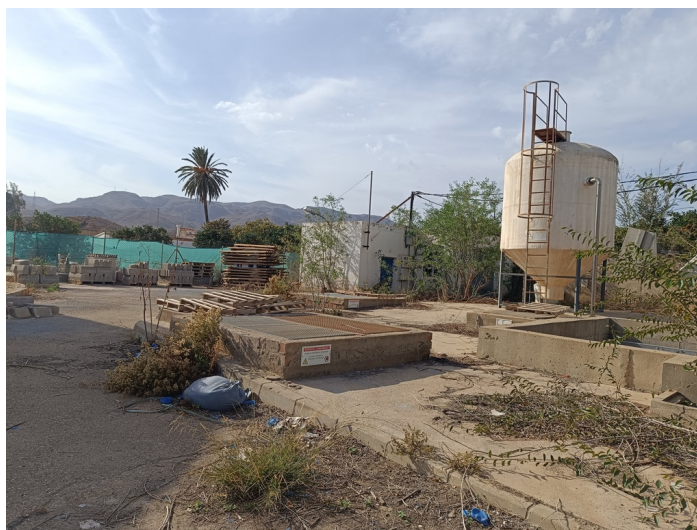
EDAR Estación Depuradora DS. CM Pechina
