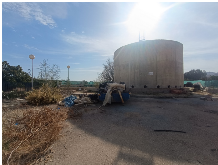
EDAR Estación Depuradora DS. CM Pechina
