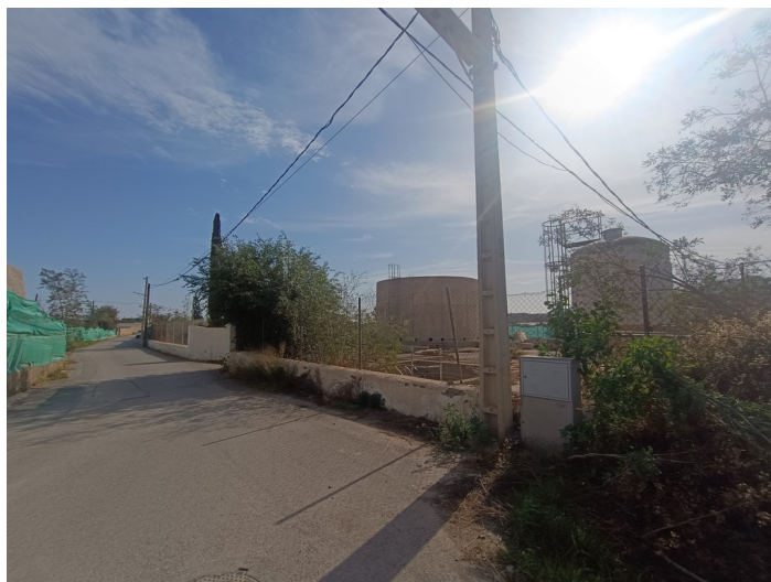
EDAR Estación Depuradora DS. CM Pechina
