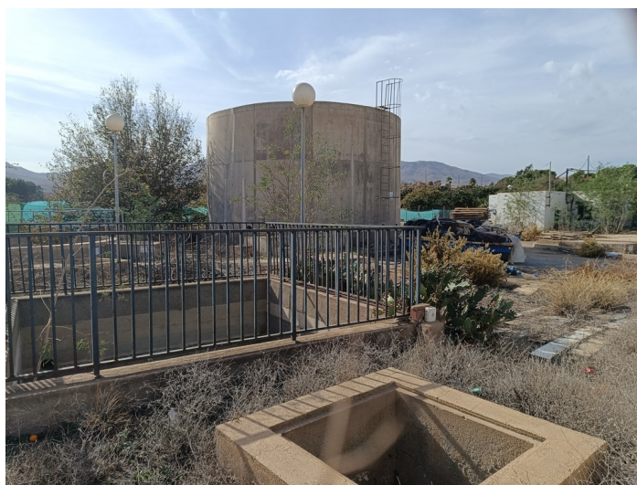
EDAR Estación Depuradora DS. CM Pechina
