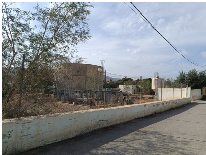
EDAR Estación Depuradora DS. CM Pechina
