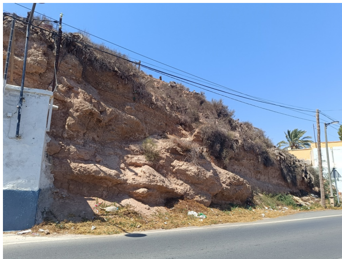
Solar Barrio El Chuche 84
