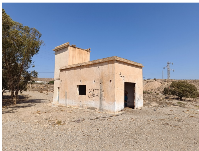
Transformador eléctrico DS La Viña
