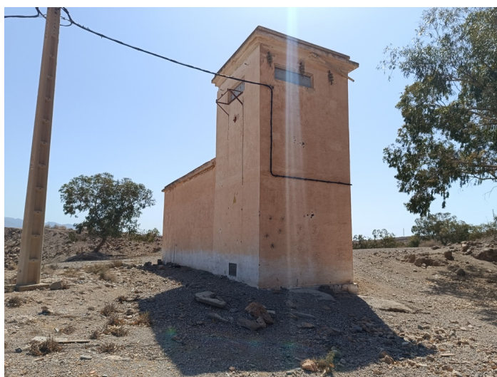
Transformador eléctrico DS La Viña
