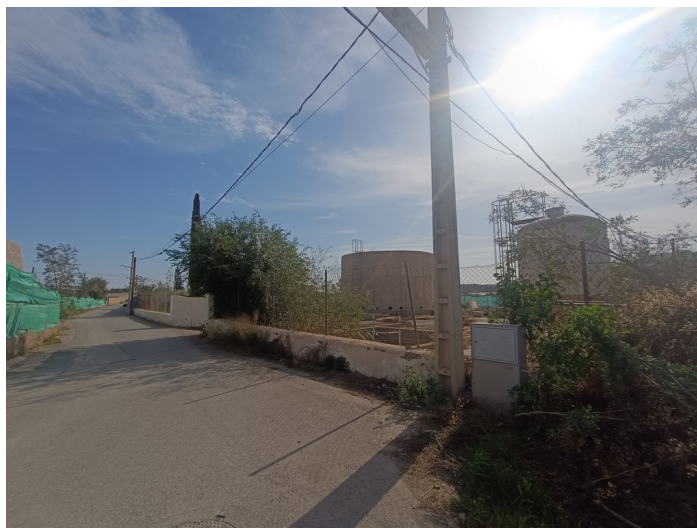
Terreno EDAR Estación Depuradora DS. CM Pechina
