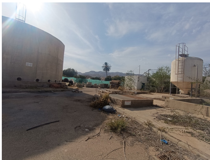
Terreno EDAR Estación Depuradora DS. CM Pechina
