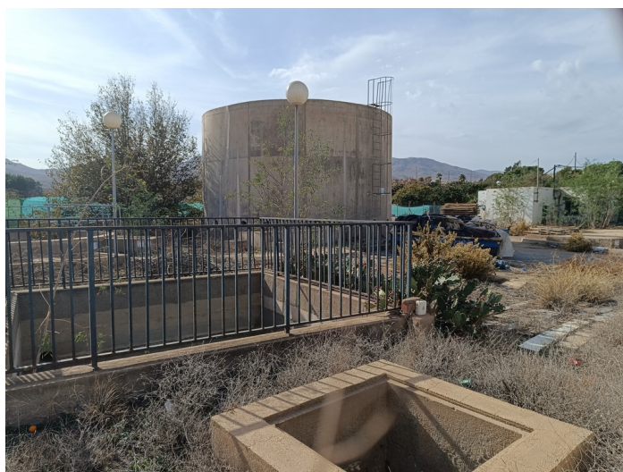
Terreno EDAR Estación Depuradora DS. CM Pechina
