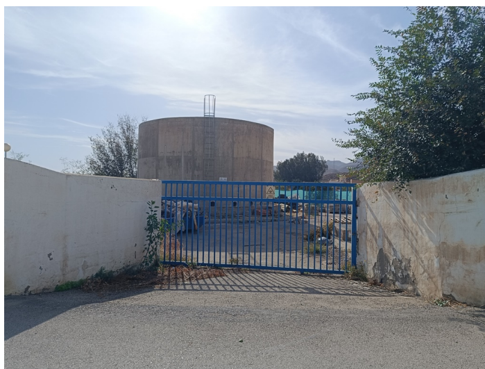
Terreno EDAR Estación Depuradora DS. CM Pechina
