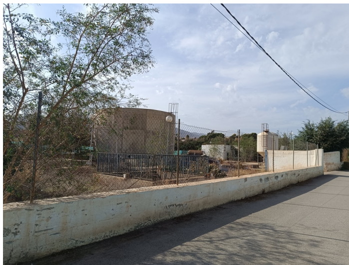
Terreno EDAR Estación Depuradora DS. CM Pechina
