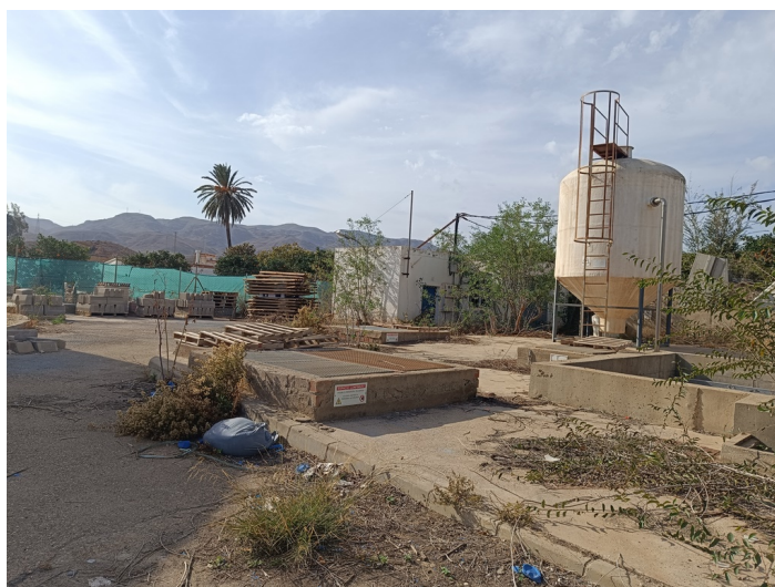
Terreno EDAR Estación Depuradora DS. CM Pechina
