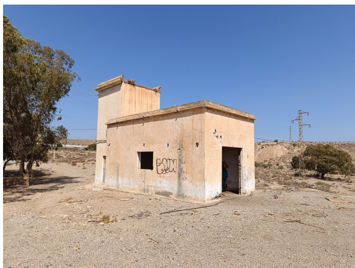
Terreno Transformador eléctrico DS La Viña
