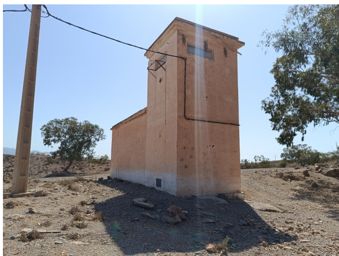
Terreno Transformador eléctrico DS La Viña
