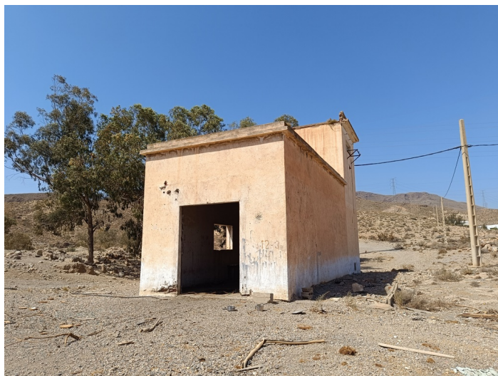
Terreno Transformador eléctrico DS La Viña
