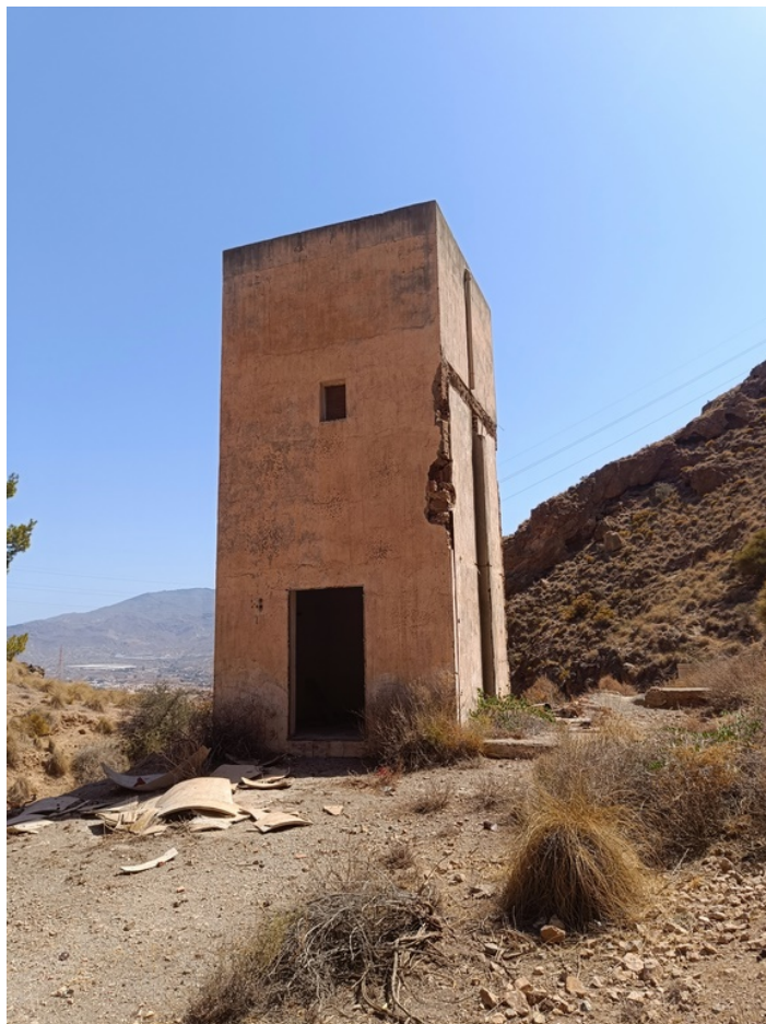
Terreno Transformador eléctrico DS La Viña 4
