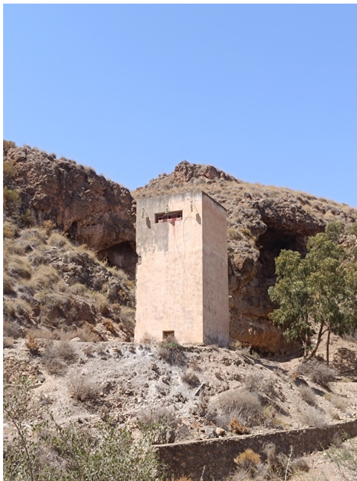
Terreno Transformador eléctrico DS La Viña 4
