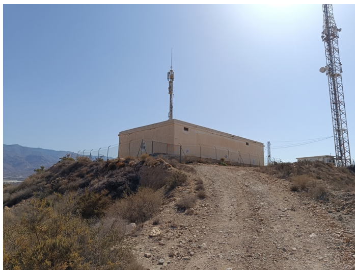
Terreno Depósito Nuevo para el Agua
