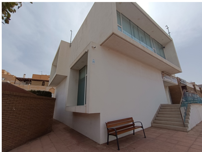
Vista exterior de la fachada
