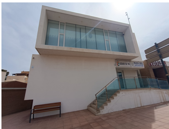
Vista exterior de la fachada
