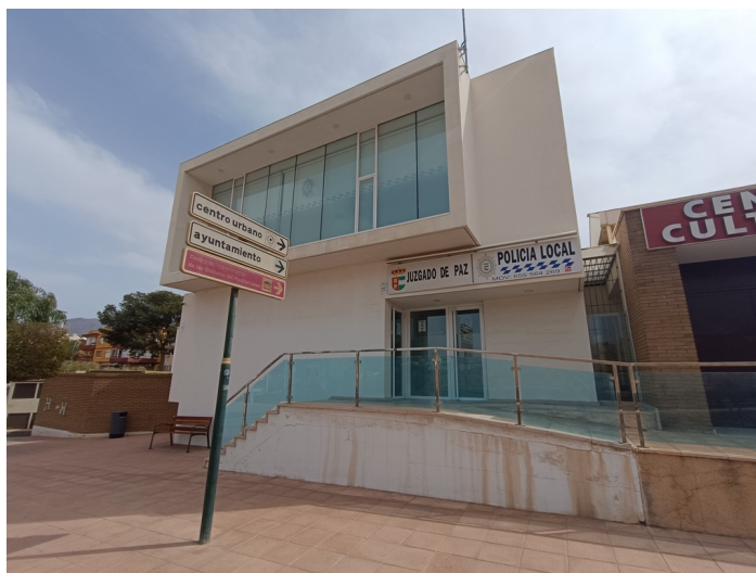
Vista exterior de la fachada
