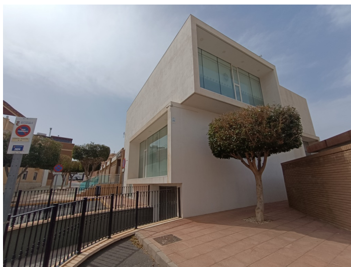
Vista exterior de la fachada
