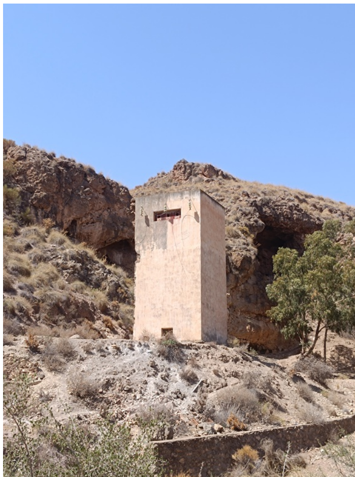
Transformador eléctrico DS La Viña 4
