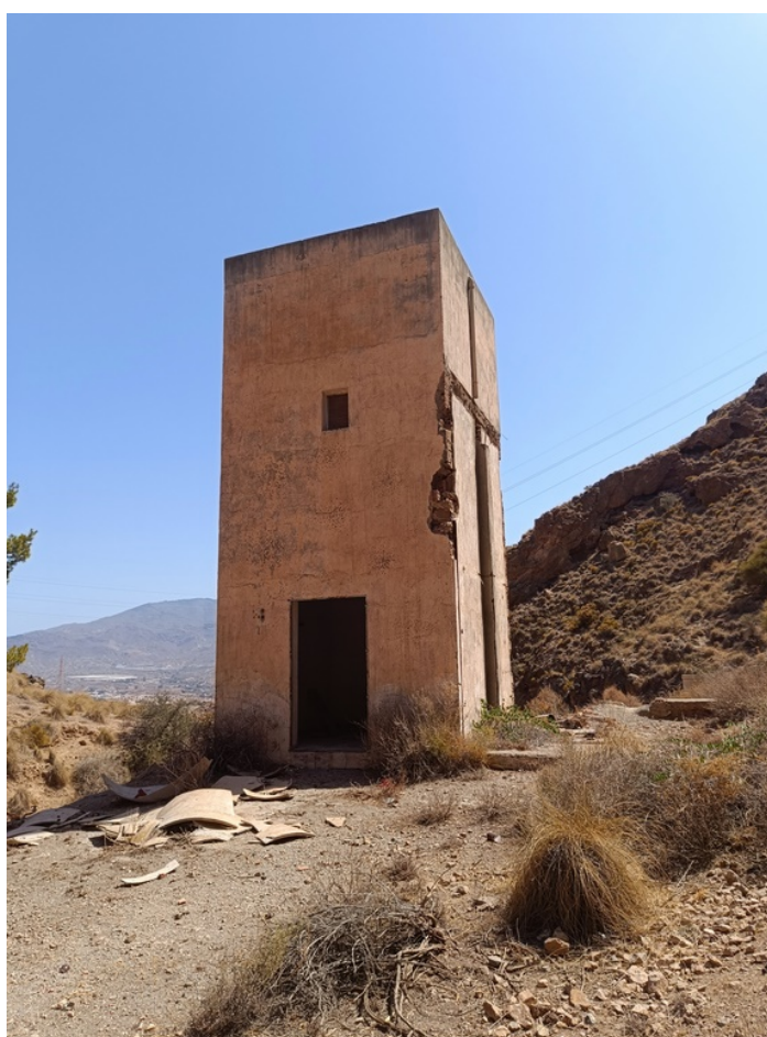
Transformador eléctrico DS La Viña 4
