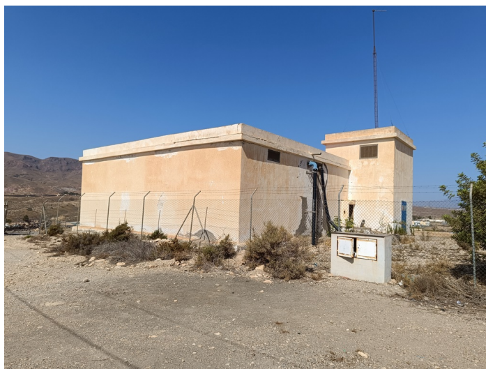
Depósito Nuevo para el Agua
