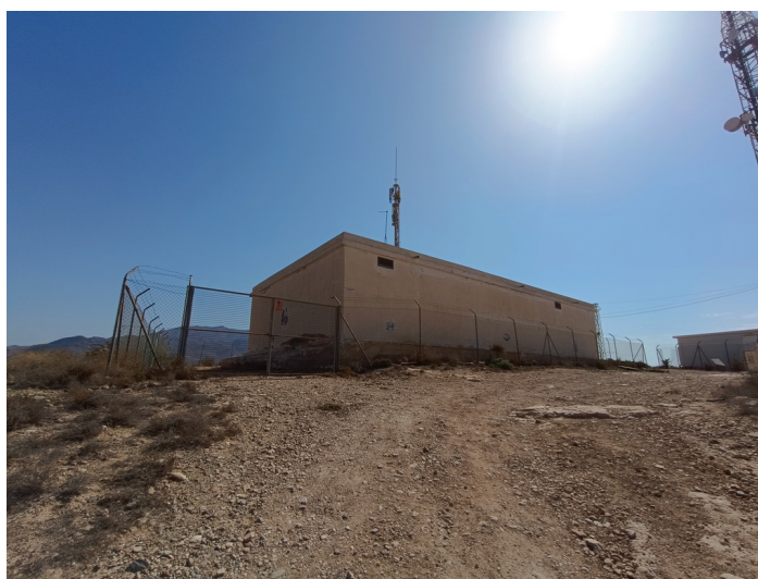
Depósito Nuevo para el Agua
