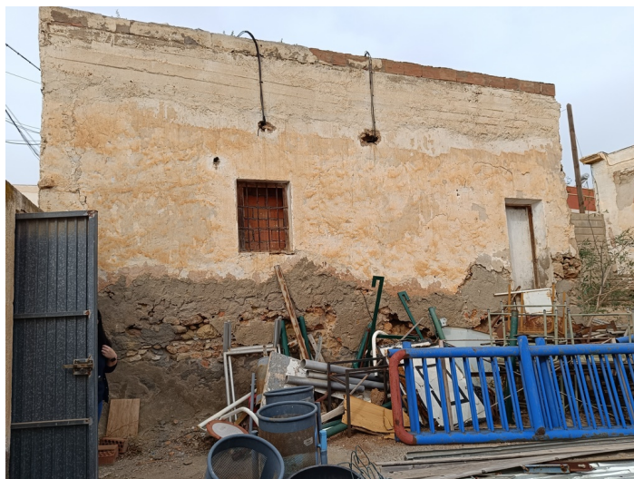
Fachada desde Almacén
