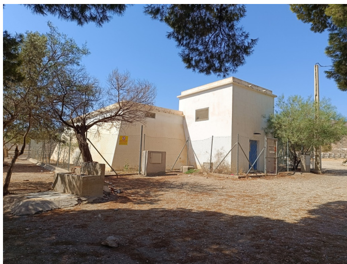
Depósitos Viejos de Agua
