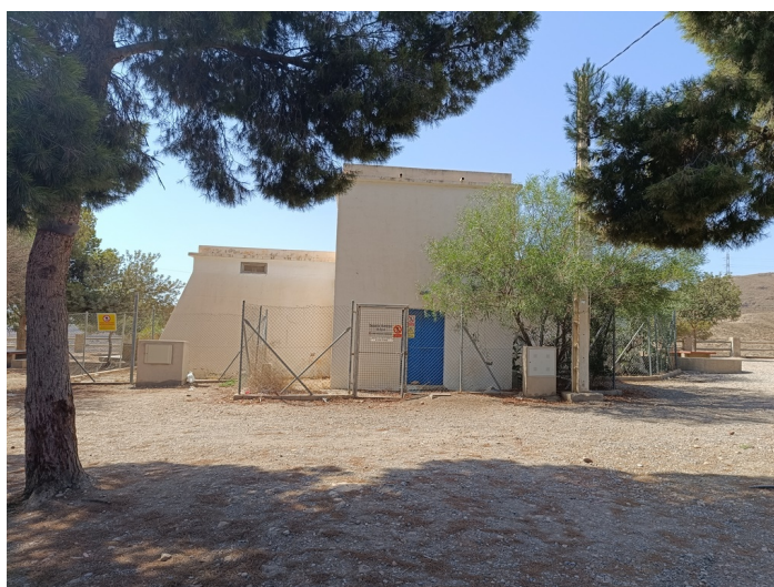
Depósitos Viejos de Agua
